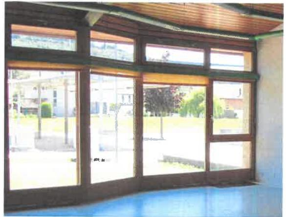
Les travaux prévus impliquent d'enlever et évacuer les anciennes fenêtres, de soutenir les plafonds pendant les travaux et de remplacer les baies vitrées par des fenêtres bois-métal en verre isolant triple, aux nouvelles normes Sigab ainsi que de remplacer les stores.
