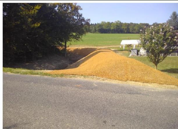
La berge gauche une fois la butte construite et recouverte d'une natte en coco. (photos : llex 2017)
