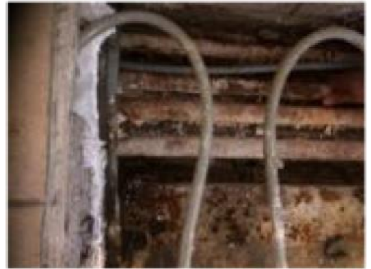
Etat des canalisations
