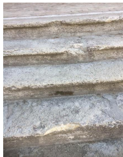
Dégâts aux marches de l'escalier
