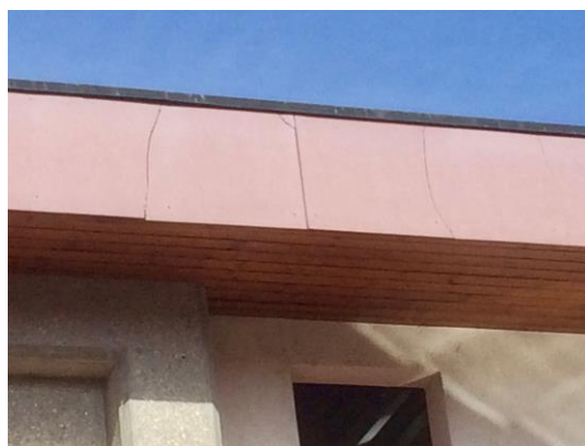
Plaques Eternit fissurées
