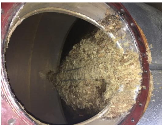
Détartrage des boilers
