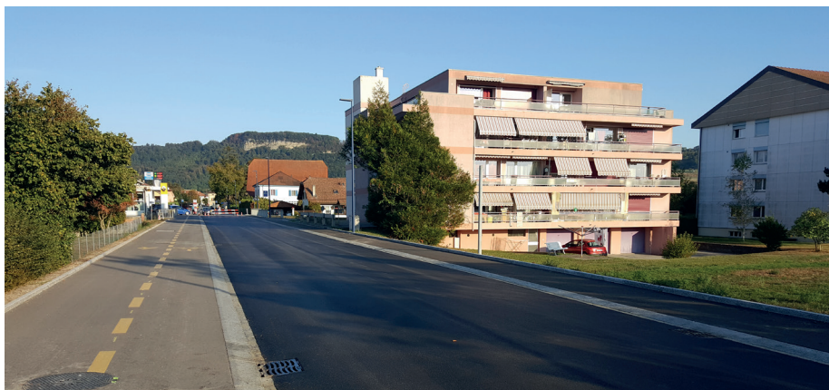
L'avenue de Mordagne le soir-même de la pose du tapis phono-absorbant.
