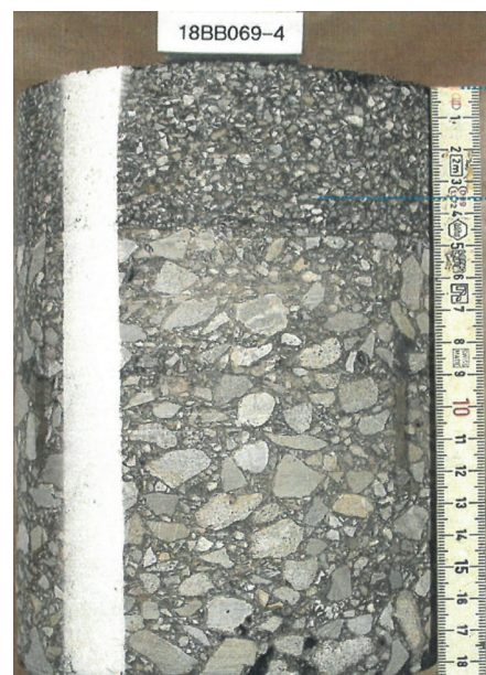
Carotte prise sur la route rénovée. La première couche plus foncée est l'enrobé phono-absorbant sur environ 5 cm. Il est posé sur une couche plus grossière d'une hauteur d'environ 13 cm. - © DR
