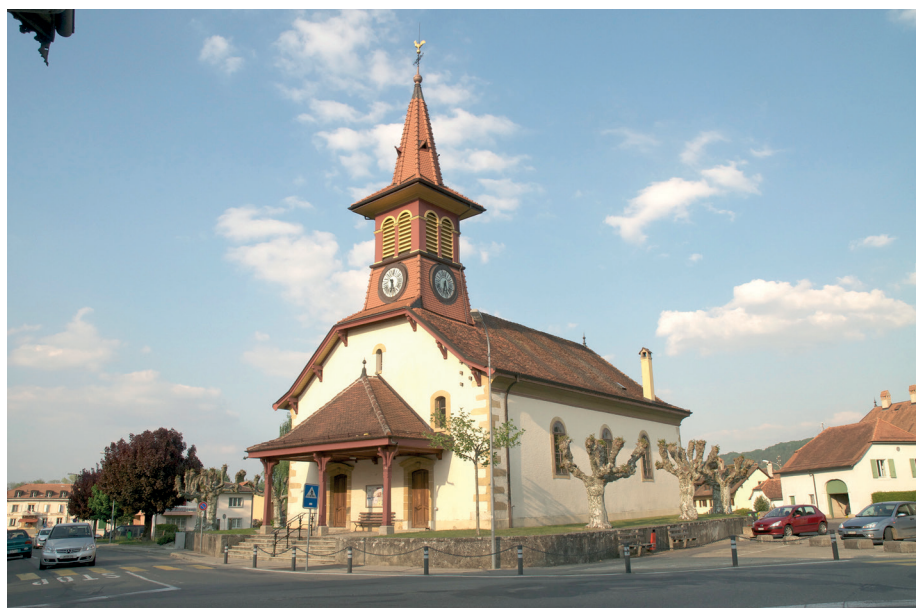
Les escaliers du temple ont été construits avec de la pierre de la Molière.
