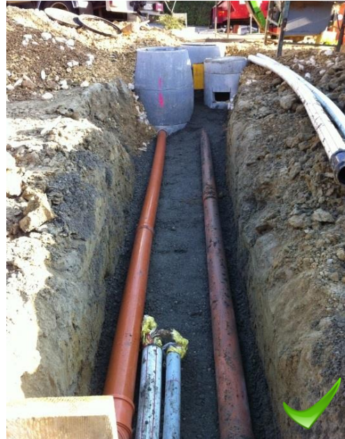
Canalisations AVEC assise bétonnée
