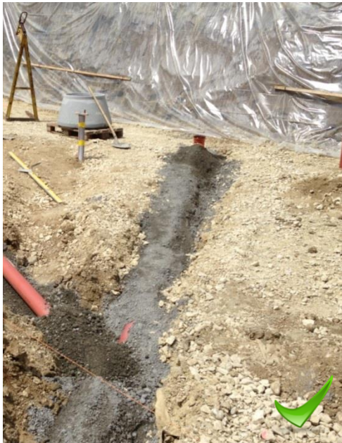
Canalisations en cours de bétonnage
