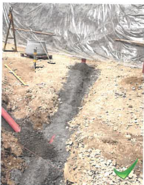
Canalisations en cours de bétonnage
