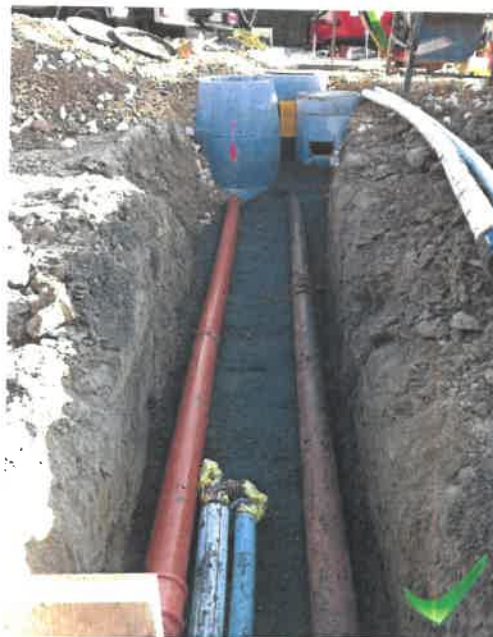
Canalisations AVEC assise bétonnée
